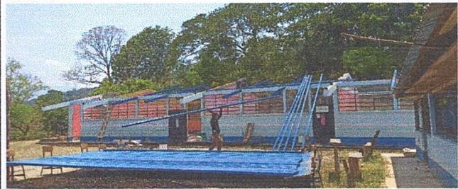
**Foto 2: Cambio de la estructura de techo de modulo 1**
