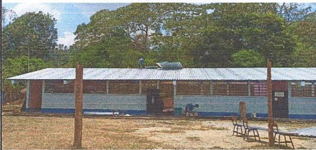
**Foto 3: Instalacion de laminas traqueladas calibre 26 modulo 1**
