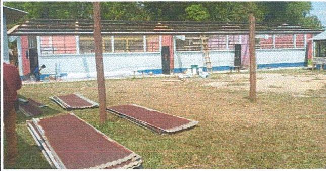
Foto 1: Cambio de lamina troquelada calibre 26 Modulo 1
