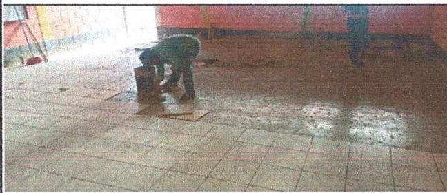
**Foto 1: Colocacion de piso ceramico antideslizante Modulo 1**
